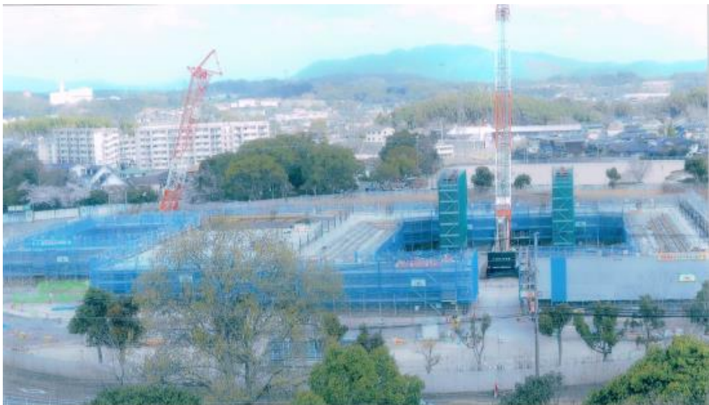
（新体育館の基礎部分の施行が進んでいます。令和4年3月27日撮影）
